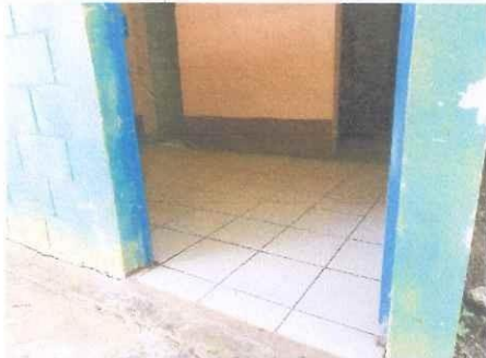
Foto7: MEJORAMIENTO PISO DE CONCRETO A CERAMICO EN DIRECCION
