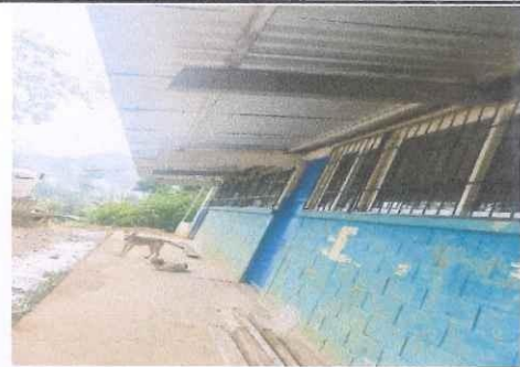
Foto 4: MEJORAMIENTO DE VENTANERIA
