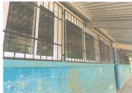
Foto 2: MEJORAMIENTO DE VENTANERIA FRONTAL
