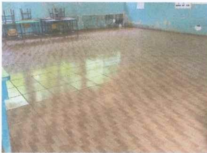
Foto 3: MEJORAMIENTO DE PISO DE CONCRETO A CERAMICO
