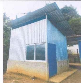
Foto 6: MEJORAMIENTO DE COCINA
