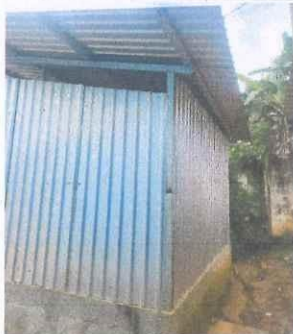
Foto 5: MEJORAMIENTO DE COCINA - CERRAMIENTO
