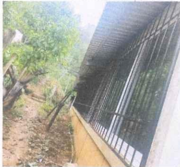
Foto1: MEJORAMIENTO DE VENTANERIA TRASERA
